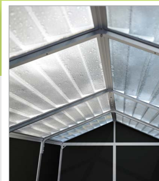
Střecha s praktickým prosvětlením interiéru
